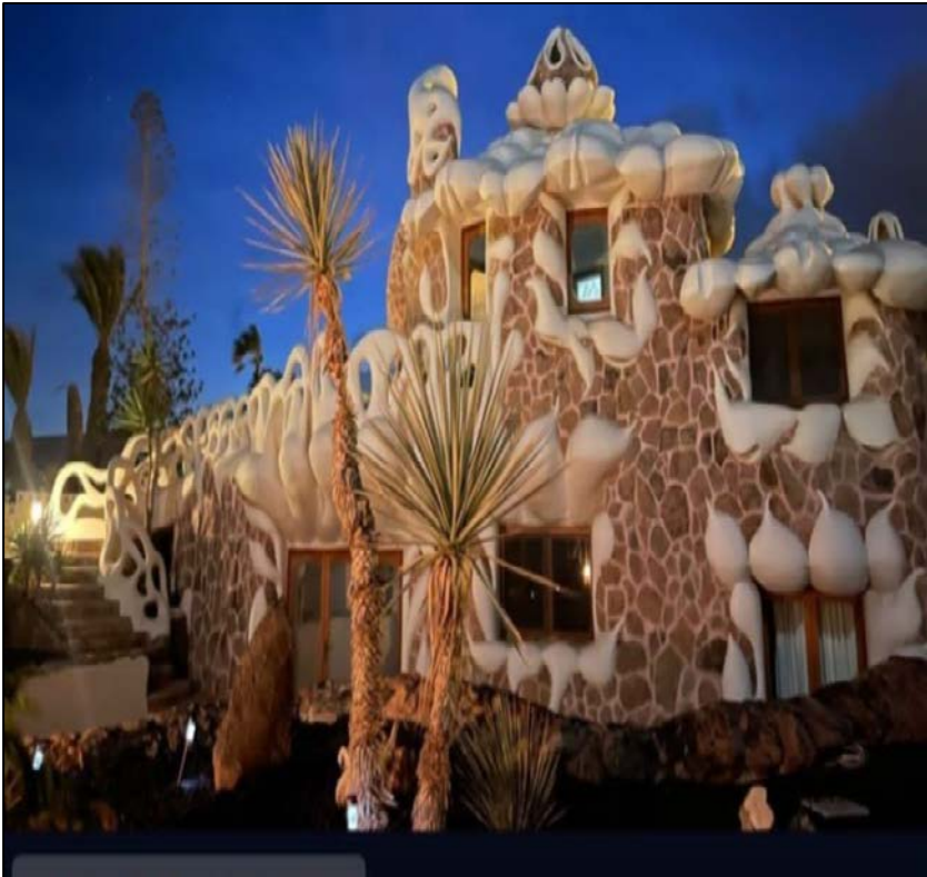
“Casa de la Ilusión”. Fachada Sur.
